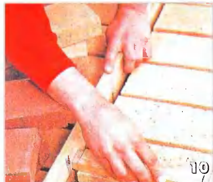
10 В качестве прокладок между плитками можно использовать небольшие бруски из дерева. Упором послужит строганая рейка
