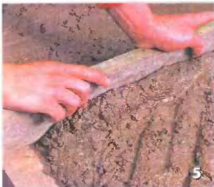
5 Сначала бетон грубо затирают по всей поверхности, выравнивая его с краями опалубки
