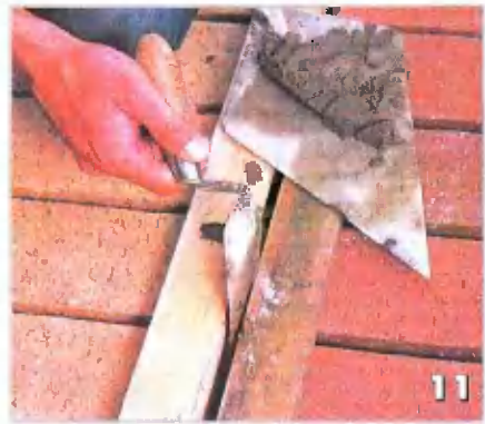
11 После схватывания раствора под плитками расширяют швы. Уложенные сверху доски защищают плитки от раствора
