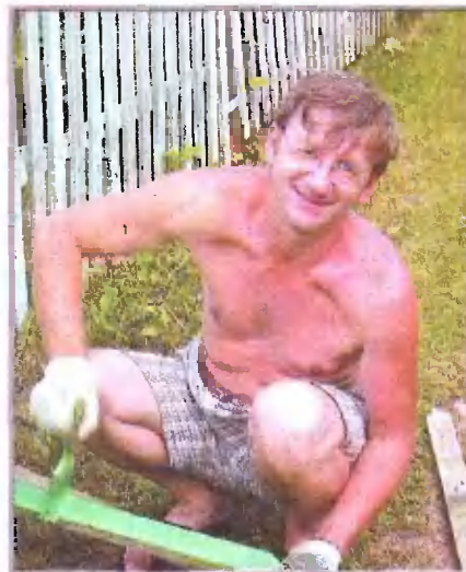
Расстояние между соседними досками в заборе из штакетника равно ширине планки. Шнур из прочной нити позволяет контролировать высоту забора
