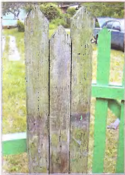
Расстояние между соседними досками в заборе из штакетника равно ширине планки. Шнур из прочной нити позволяет контролировать высоту забора
