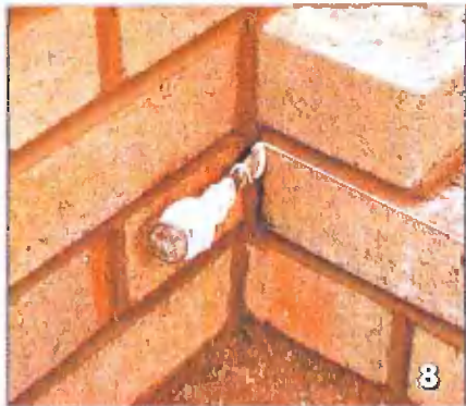
8 В углу шнур можно закрепить в свежем шве с помощью отвертки
