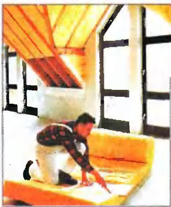
Здесь показано устройство крыши с размещением утеплителя между стропилами: 1 — гидро-ветрозащитная пленка; 2 — пароизоляционная пленка
