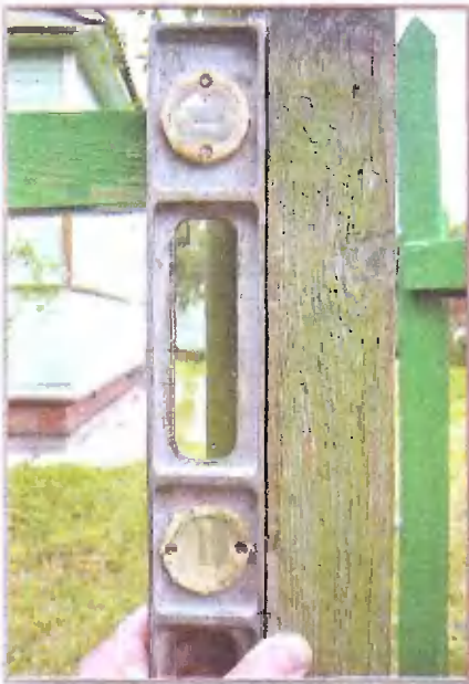
Первую штакетину устанавливал по уровню и периодически проверял вертикальность следующих
