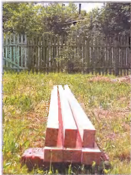
В качестве поперечин для нового забора мы использовали брус сечением 40x50 мм из лиственницы. Его необходимо покрасить до начала монтажа
