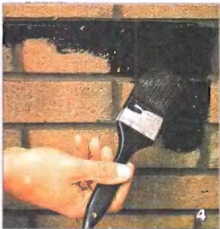
Если чаши для цветов примыкают к стене дома, контактирующую с ними поверхность стены тоже изолируют
