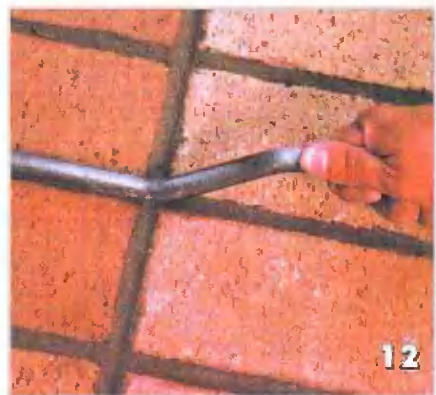
12 Швы разглаживают расшивкой. Чтобы на плитках не скапливалась вода, швы слегка заглубляют
