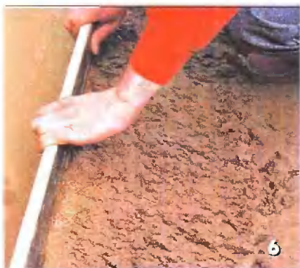
6 Затем бетон заглаживают, как того требует основание под покрытие пола
