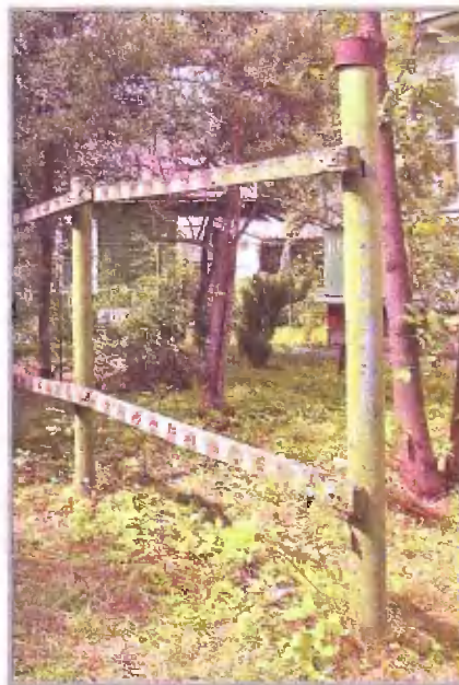
Работу начали с демонтажа старого забора. Его ремонтировали секциями, чтобы не открывать доступ на участок
