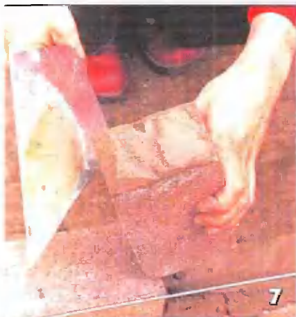
7 Шнур обности натягивают на уровне верхней кромки первого ряда кирпичей и заподлицо с наружной кромкой стены. Нанеся раствор на торец кирпича, его вдавливают в уложенный на нижнем ряду раствор, слегка двигая из стороны в сторону
