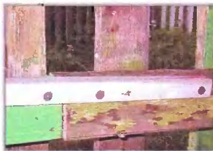
Новую и старую части забора я временно соединял металлическим уголком. Шурупы завинчены только в боковую часть бруса
