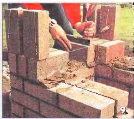
9 В верхнем ряду кирпичи кладут на ребро
